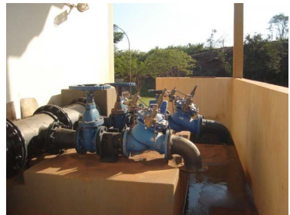
Figura 5.38:Captação - Início da linha de recalque e válvulas de alívio para o controle de transiente hidráulico.
