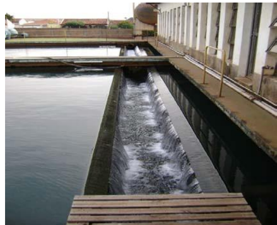
Figura 5.15: Calhas de coleta de água decantada.
