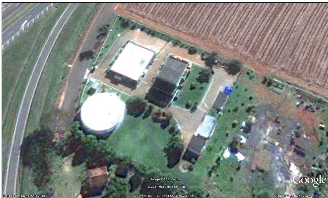
Figura 5.30: Imagem de satélite da ETA Águas de Mandaguahy e local do poço profundo que explora o Aquífero Guarani.
