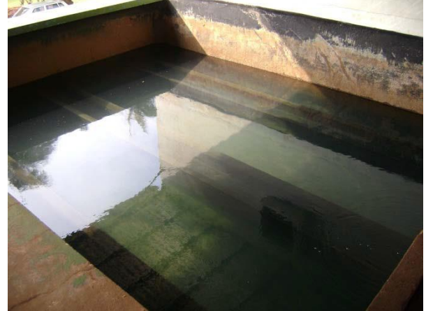
Figura 5.17: Destaque de filtro em operação.
