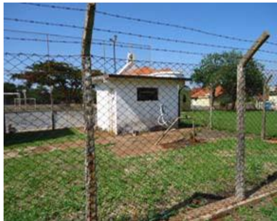
Figura 10.2 - Poço mais antigo e junto e ao reservatório.
