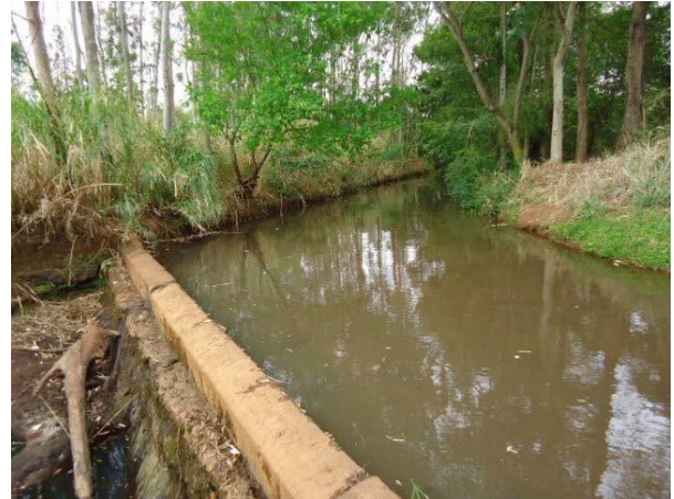
Figura 5.5: Captação no Córrego Sto. Antônio, vista do vertedor e trecho seco a jusante.
