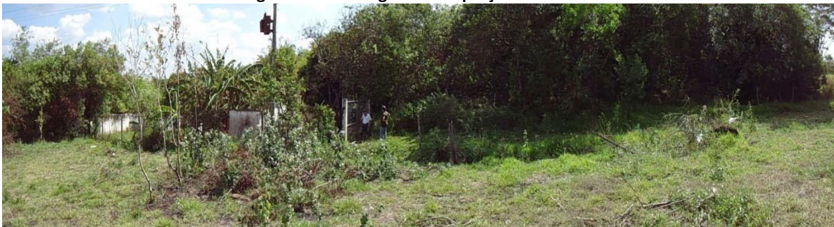
Figura 5.26: Vista geral da Captação dos Pires.
