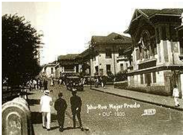
Foto 4 - Rua Major Prado em 1930
