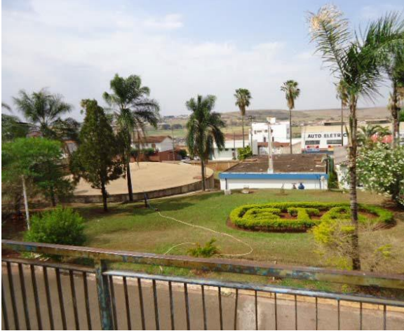
Figura 5.60: Centro de reservação ETA I - Vista dos reservatórios R1 e R'1.
