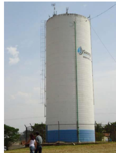
Figura 5.81: Centro de reservação Jd. São José - Reservatório R11.
