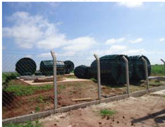
Figura 10.10 - Local de implantação da ETE do Bairro Nova Olaria.
