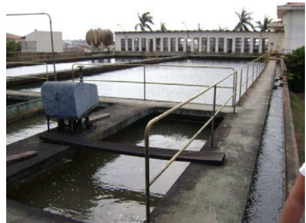
Figura 5.15: Calhas de coleta de água decantada.
