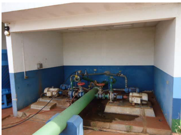
Figura 5.92: Conjunto de bombas da estação elevatória Jd. Nova JAHU.
