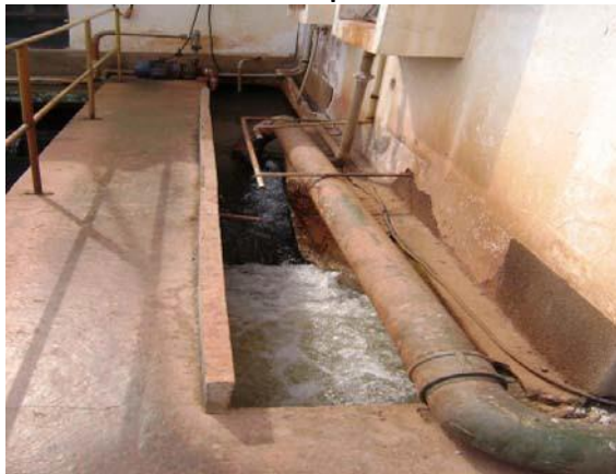
Figura 5.12: Canal de chegada da água bruta com destaque para o ressalto hidráulico existente na calha Parhall e a adutora de água bruta da Represa São Joaquim.
