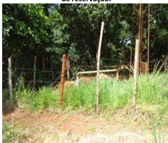
Figura 10.6 - Poço raso localizado distante do centro de reservação.
