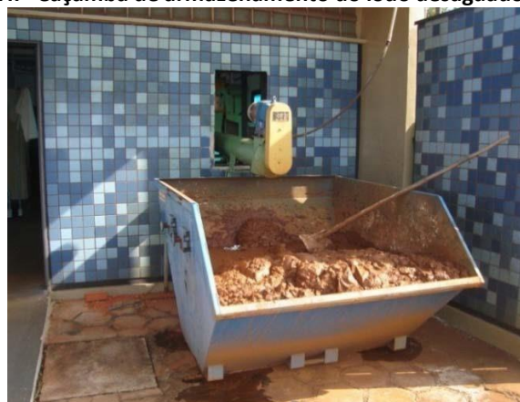
Figura 5.45: ETA II - Caçamba de armazenamento do lodo desaguado pela centrífuga.
