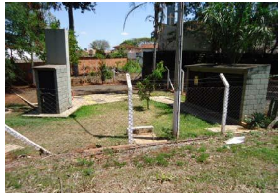
Figura 5.74: Centro de reservação Fórum – Estação Elevatória de Esgoto localizada junto ao centro.
