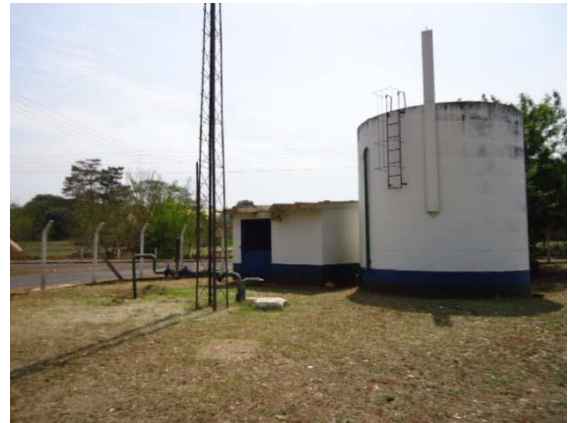
Figura 5.79: Centro de reservação Julhinho de Carvalho - Reservatório RP6.
