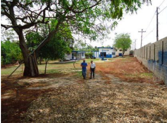
Figura 5.76: Vista geral do centro de reservação ETA III.
