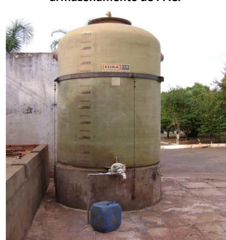
Figura 5.21: Tanque estacionário destinado ao armazenamento de PAC.
