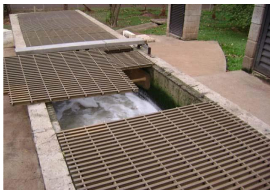
Figura 6.9: Canal de saída do efluente tratado.
