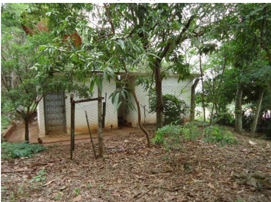
Figura 10.14 - Reservatório de abastecimento da zona baixa, local do sistema de tratamento e elevatória de abastecimento do reservatório da zona alta.
