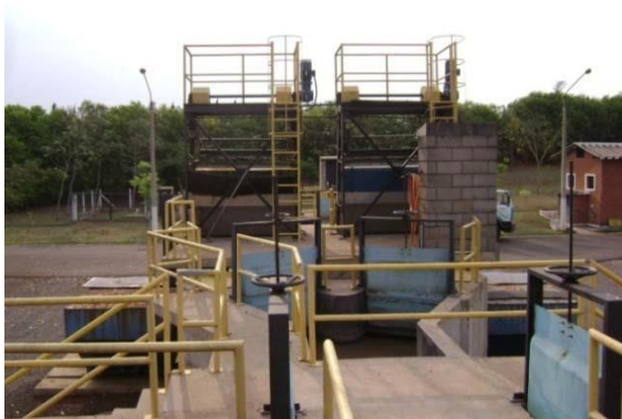
Figura 6.7: Vista dos Digestores de lodo descartado. No fundo do tanque, vista dos difusores do sistema de aeração.
