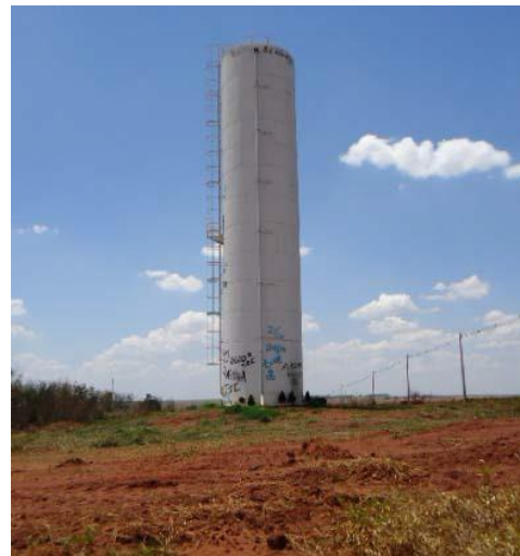
Figura 5.85: Centro de reservação Área Industrial Nova - Reservatório
