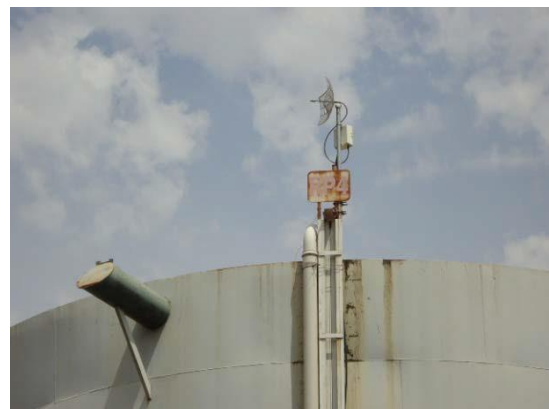
Figura 5.87: Sistema de telemetria.
