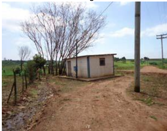
Figura 10.9 - Estação elevatória do sistema de afastamento dos esgotos sanitários.
