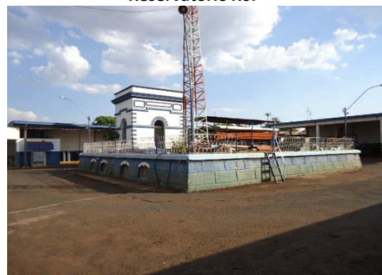
Figura 5.64: Centro de reservação Vila Nova – Reservatório R0.
